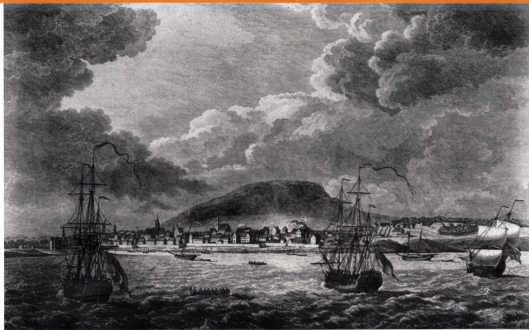
La Vue Orientale de MONTREAL, en Canada
